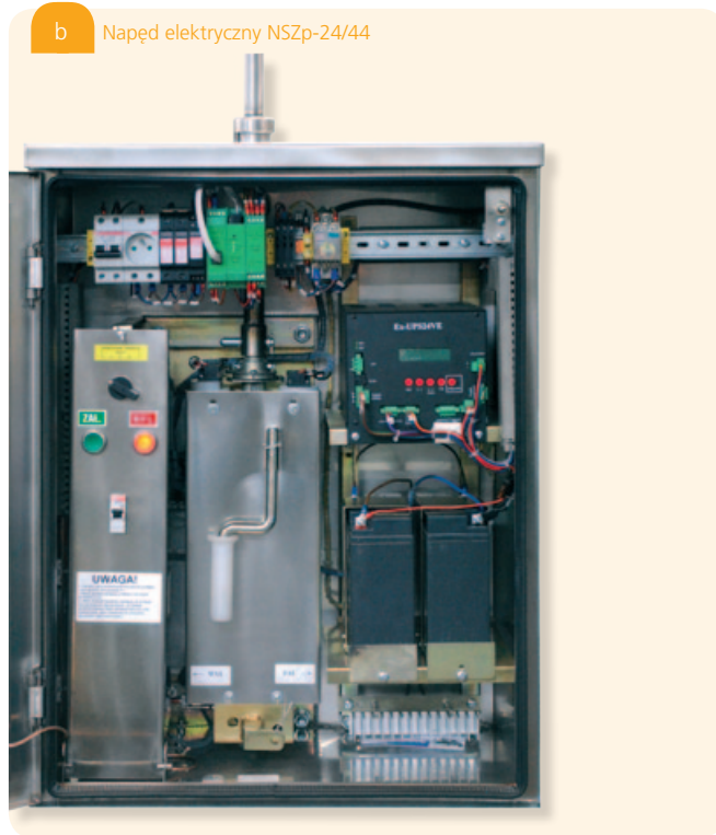
d Napęd elektryczny NSZpp-24/44
