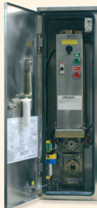
c Napęd elektryczny (wewnętrzny) NSWop - widok wewnętrzny
